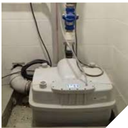
Montajı yapılmış SANICUBIC 2 Classic
