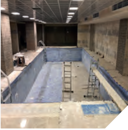
-2 bodrum kattaki havuz
