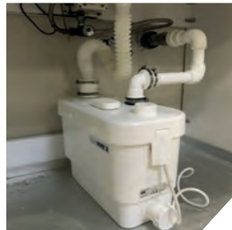
Lavabo altına kurulan SANIVITE
