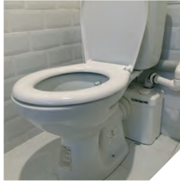
Klozetin arkasına monte edilmiş SANITOP
