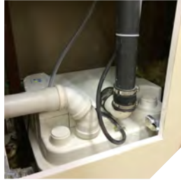
Alçıpan içine gizlenmiş SANICUBIC 1 WP
