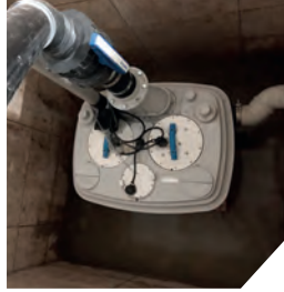
Kuyuya yerleştirilen SANICUBIC 2 VX
