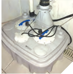
-2. kattaki depoya kurulan SANICUBIC 2 VX
