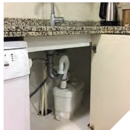
Tezgâhın altına gizlenmiş SANIVITE pompa
