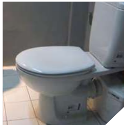
Klozetin arkasına monte edilmiş SANIPRO XR
