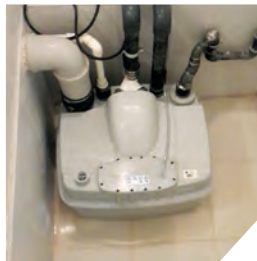
Tuvaletlerle aynı kattaki SANICUBIC 2 Classic
