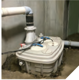
Montajı yapılmış SANICUBIC 2 VX
