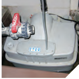
Makine odasına kurulan SANICUBIC 2 Classic
