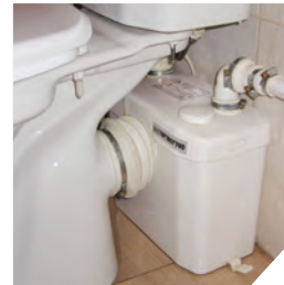
Klozete monte edilmiş SANITOP
