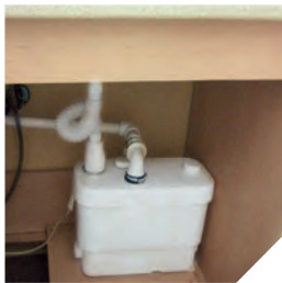
Mutfak evyesinin altına gizlenmiş SANIVITE pompa
