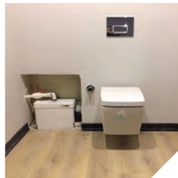
Duvara gömülüp kapakla gizlenecek SANIPACK
